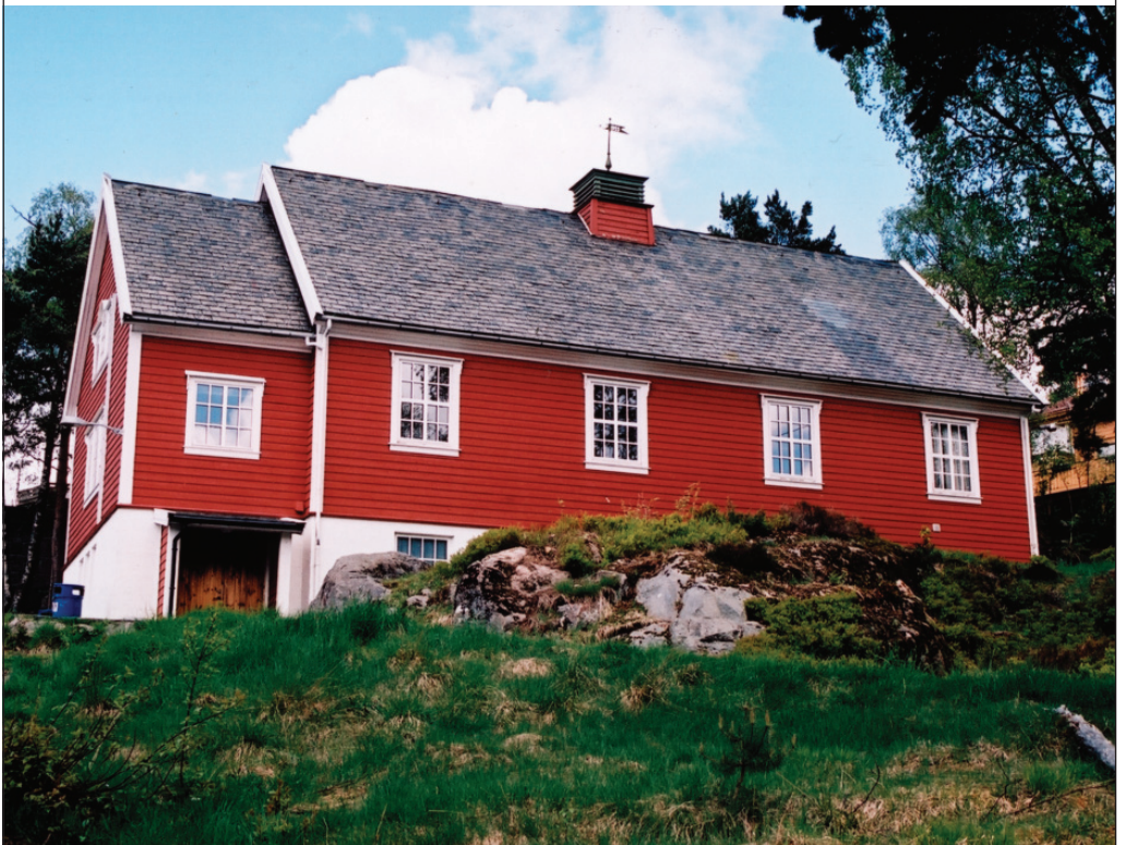
Ungdomshuset Trudvang i Fyllingsdalen
